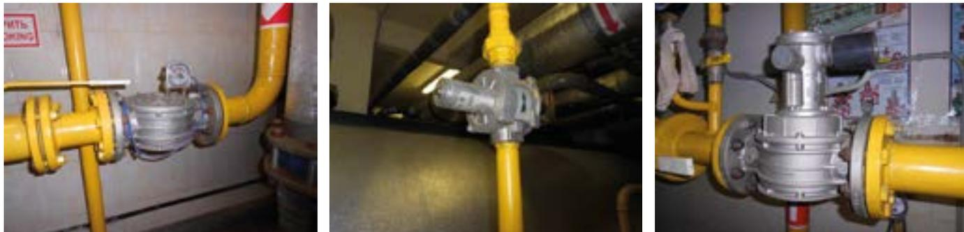
ГАЗОВАЯ РАМПА ГАЗОПРОШНЕВОЙ УСТАНОВКИ.
